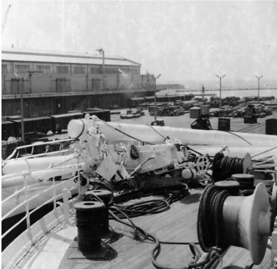
Nach der Havarie im März 1959 in Marseille
