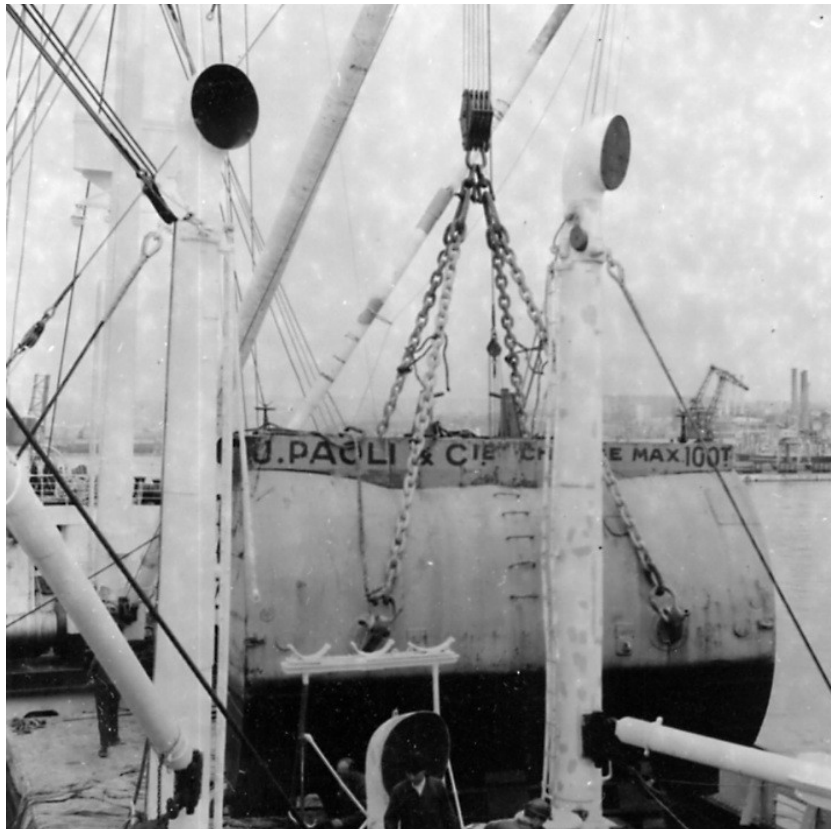
Der Mast und der Schwergutbaum werden mit einem Wassertank getestet. Durch das Einfüllen von Wasser in den geeichten Tank konnte man das Testgewicht genau bestimmen.
