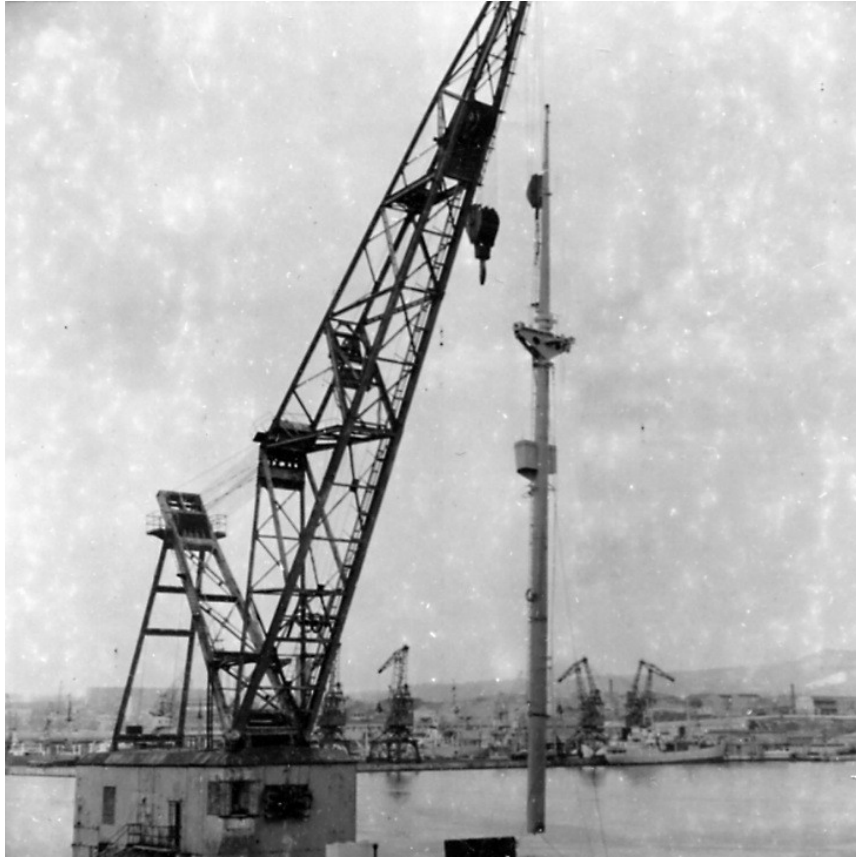
Der neue Mast wird mit einem Schwimmkran eingesetzt
