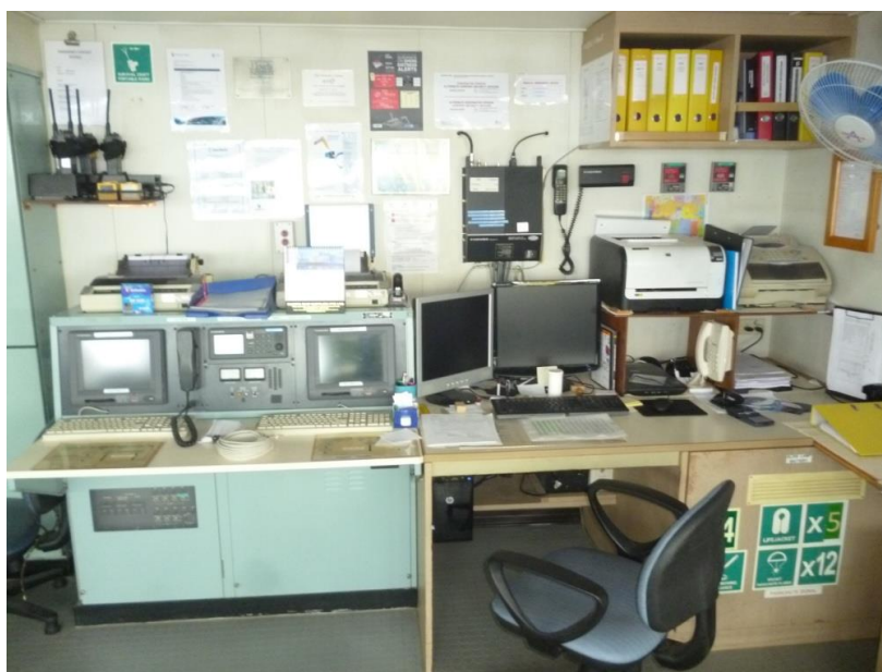
La console di comunicazione (sulla sinistra) per il traffico commerciale e GMDSS per l'area A3 sulla nave SCL BERN (Foto Stefan Sip)
